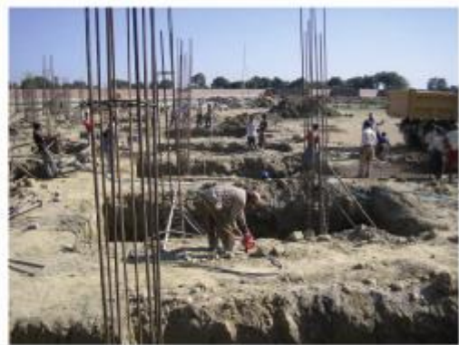
Der Bau startete im Oktober
